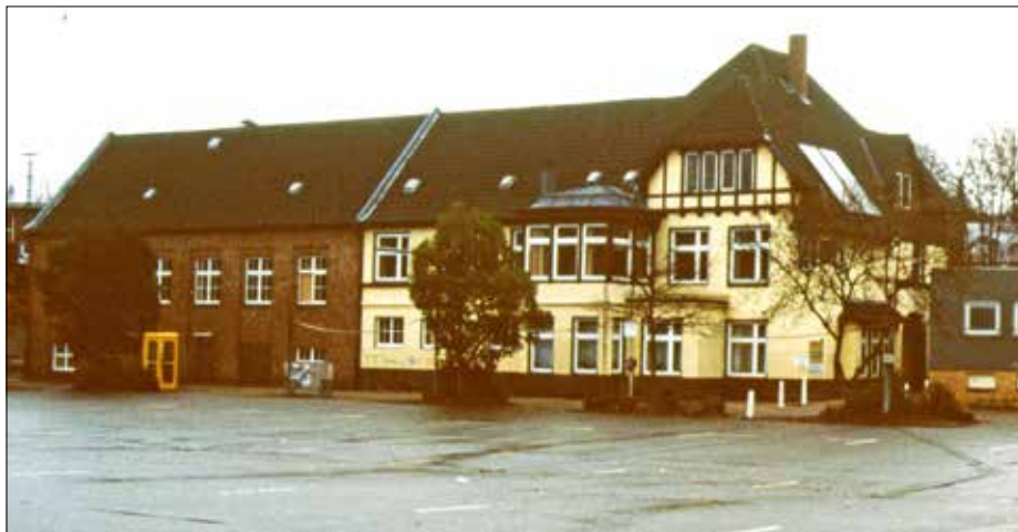
Ehemaliges Verwaltungsgebäude der Kleinbahn (gelb) und der Anbau der HEW für das Umspannwerk (heute Koralle). Die ursprüngliche Stromerzeugung fand im linken Teil des gelben Erdgeschosses statt
