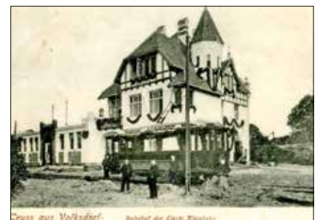
Abb. unten: Verwaltungsgebäude der Altrahlstedter-Volksdorfer Kleinbahn am Kattjahren. Das linke flache Gebäude ist die Maschinenhalle, in der der Strom erzeugt wurde
