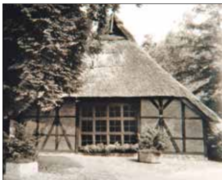
Modernisierte RäucherKate aus den 1960er-Jahren
