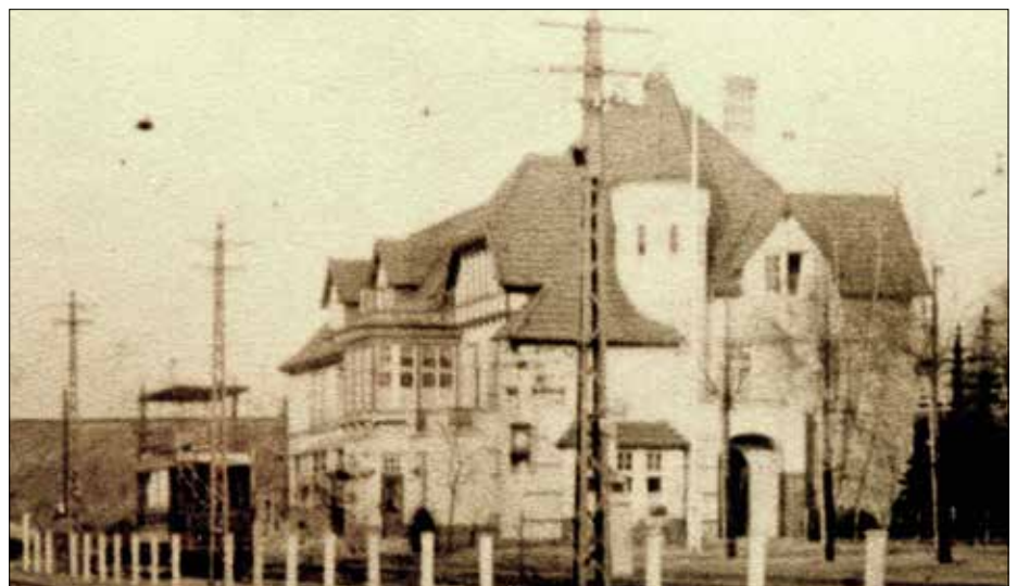
Abb. unten: Über der Maschinenhalle ist das Verwaltungsgebäude aufgestockt worden
